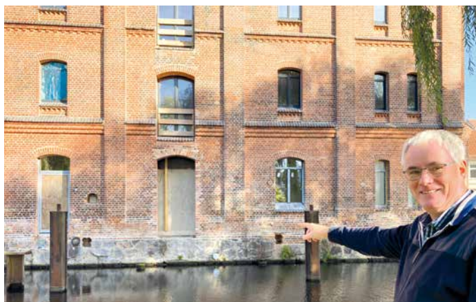
Nah an Kultur, nah am Wasser. Marko Schirrmeister zeigt: Hier soll das Restaurant, betrieben von einem inklusiven Gastro-Team, einziehen. Dann wird auch eine Terrasse zum Verweilen einladen.
